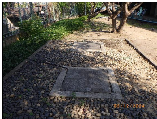
รูปที่ 17 บ่อพักก่อนระบายน้ำทิ้งลงสู่ท่อระบายน้ำสาธารณะ
