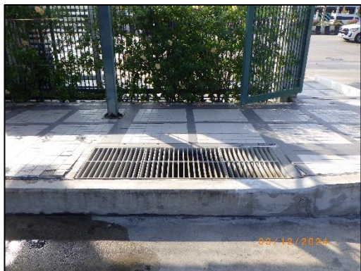
รูปที่ 17 บ่อพักก่อนระบายน้ำทิ้งลงสู่ท่อระบายน้ำสาธารณะ
